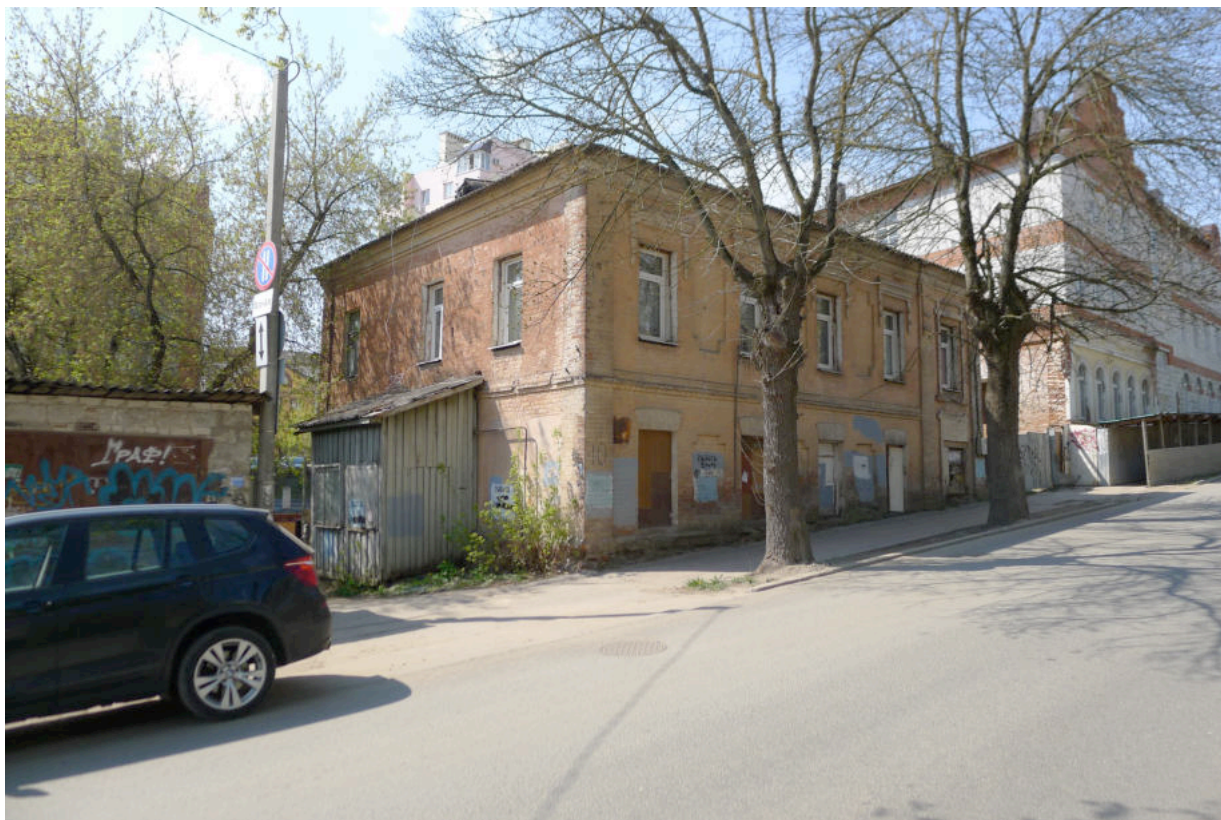
Фото 1. Дом в застройке ул. Никитина. Вид с северо-востока.
