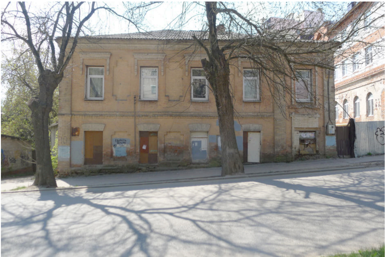
Фото 3. Главный (северный) фасад.
