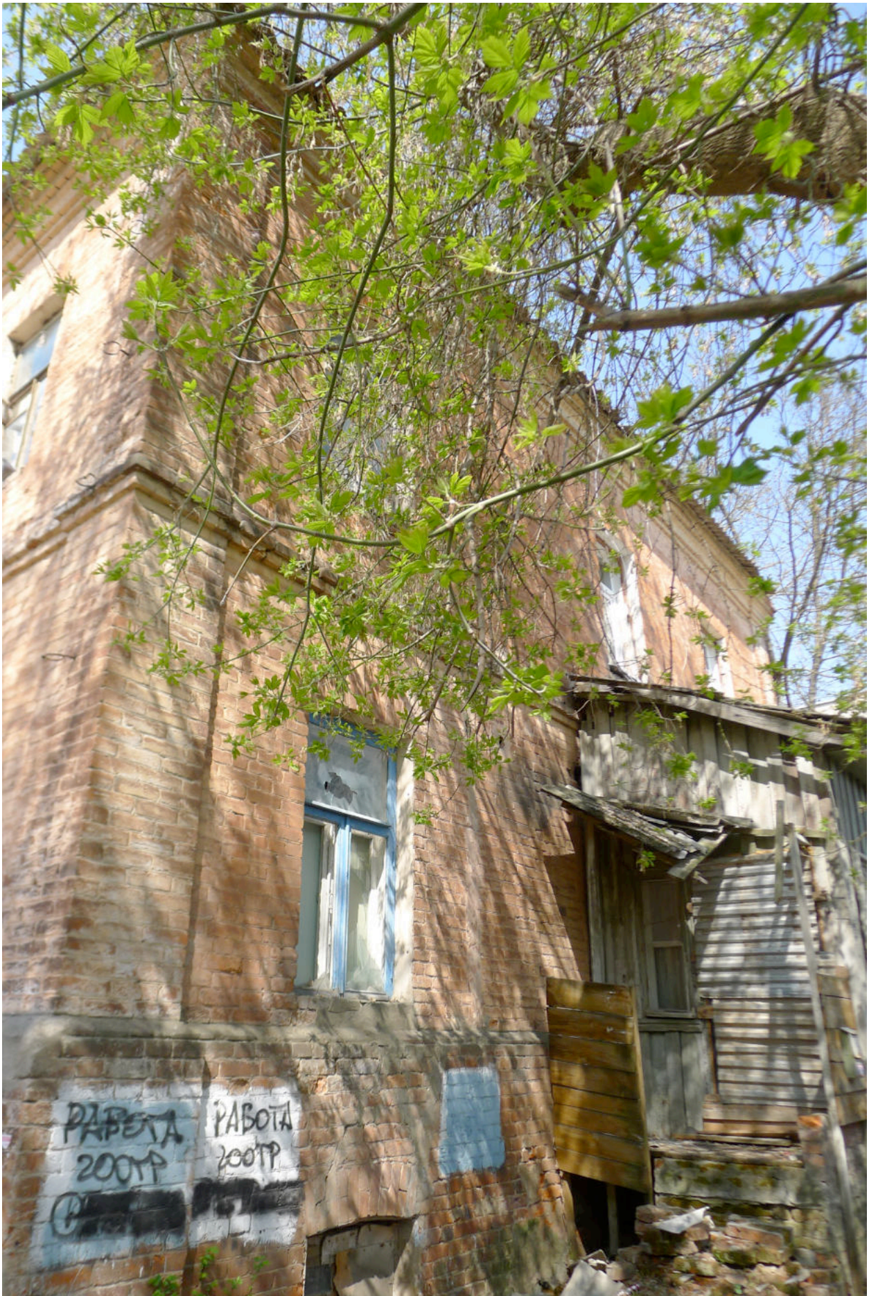
Фото 7. Южная стена здания.
