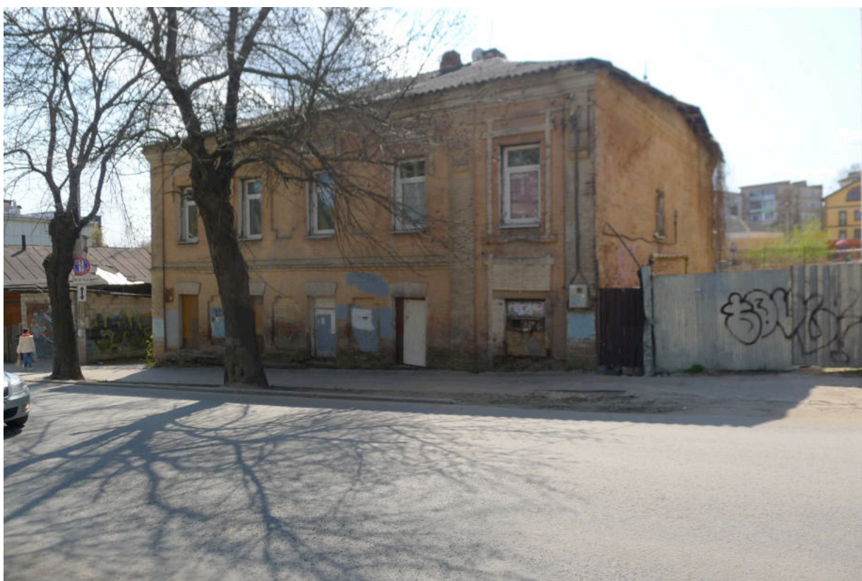
Фото 2. Вид с северо-запада.
